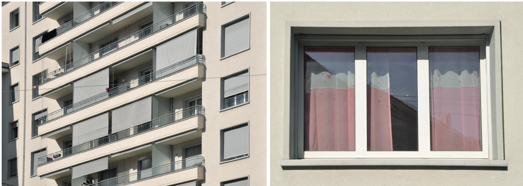
*Façade d'un bâtiment rénové avec une isolation périphérique, des encadrements en ciment.*
