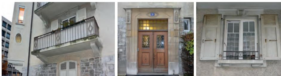
Le socle en moellons, les balcons sur consoles, les éléments de décor et les embrasures en pierre.
