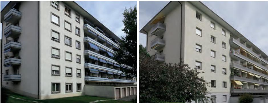
Fig. 12 et 13 À gauche, un immeuble (Lausanne) sans isolation extérieure. À droite, la diminution des vides de lumière, la modification des proportions des «pleins et vides», l'enfoncement des fenêtres, l'aplatissement de la façade due à la disparition des encadrements de fenêtres après la mise en œuvre d'une isolation extérieure sur un immeuble «jumeau».
