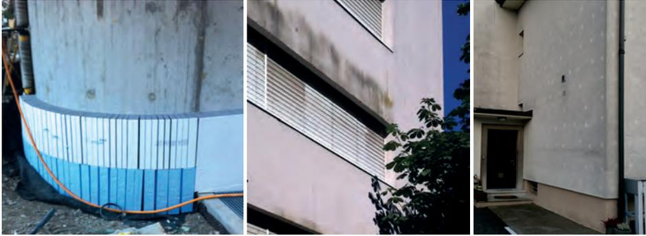
Fig. 32 à 34 De gauche à droite, les joints ouverts dans l'isolation périphérique, (Vevey). Les algues et les mousses sur le crépi posé sur l'isolation périphérique en façade nord, accentuées par la présence d'arbres, une dizaine d'années après la construction (Vevey). Et les nombreuses fixations mécaniques de l'isolation périphérique de première génération d'un bâtiment (Fribourg) qui apparaissent au travers du crépi. Aujourd'hui on doit déjà les rénover.
