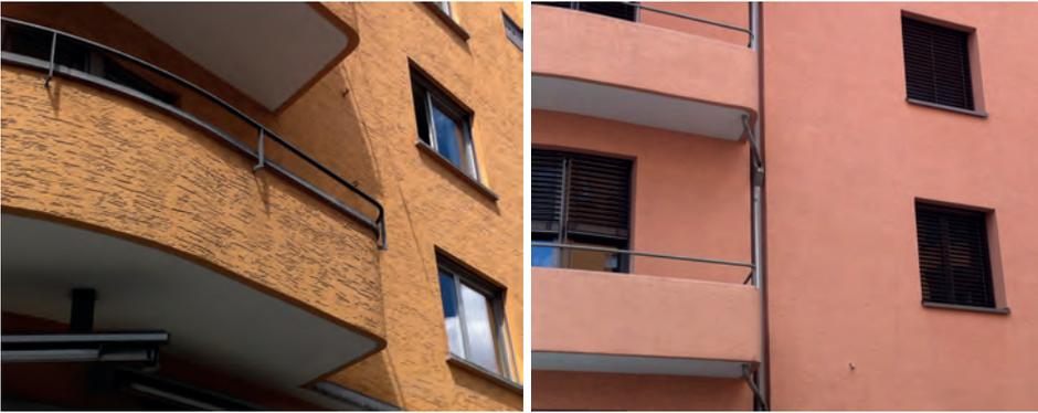
Fig. 10 et 11 À droite, substitution du crépi structuré par un aplat banal, appauvrissement des garde-corps des balcons, disparition des éléments de tablette en simili et intégration douteuse des descentes d'eau sur un bâtiment et à gauche, son «jumeau» (Zürich).
