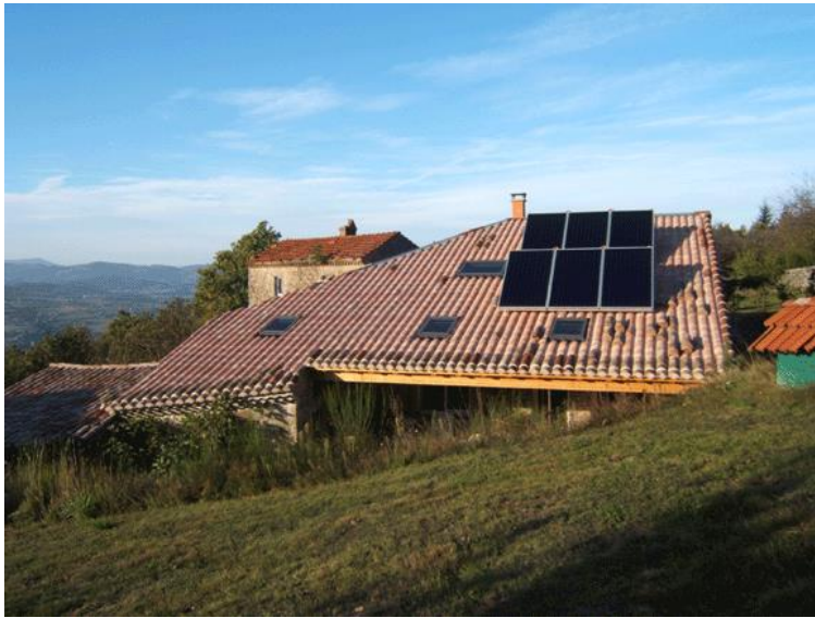
Système de pose rapportée sur support incliné 73
