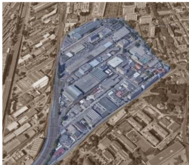
Vue aérienne actuelle du périmètre D5 PAV Grosselin
